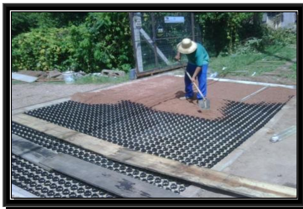
Preenchimento com colocação de brita 0
