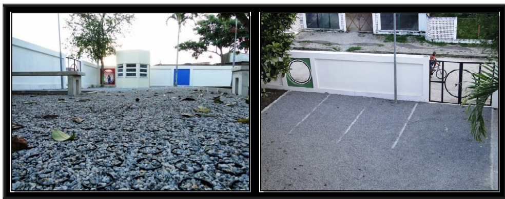
Preenchimento com colocação de brita 0
