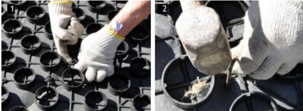
1. O Ecopavimento® é interligado entre si e disposto sobre a base preparada. Encaixe o ecopavimento com bidim um no outro e coloque sobre o solo, até formar uma malha.
