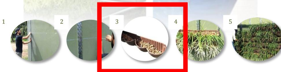
1. Marcar a localização do ponto para instalação das cremalheiras de acordo com as distâncias especificadas, furar os pontos. Os parafusos deverão ir na altura de 1m em 1m. Coloque as buchas nos furos;
